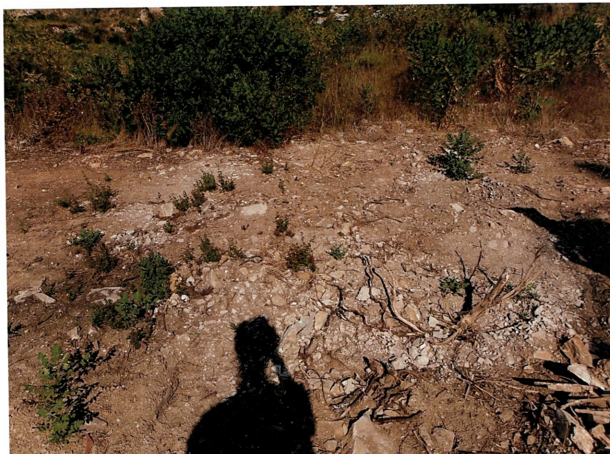
Photo n°5 : Déblais entre le poste et la voie ferrée
