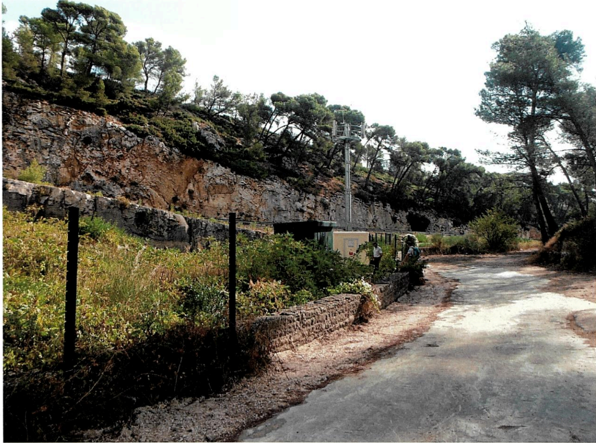
Photo n°3 : Clôture manquante et poteaux seuls
