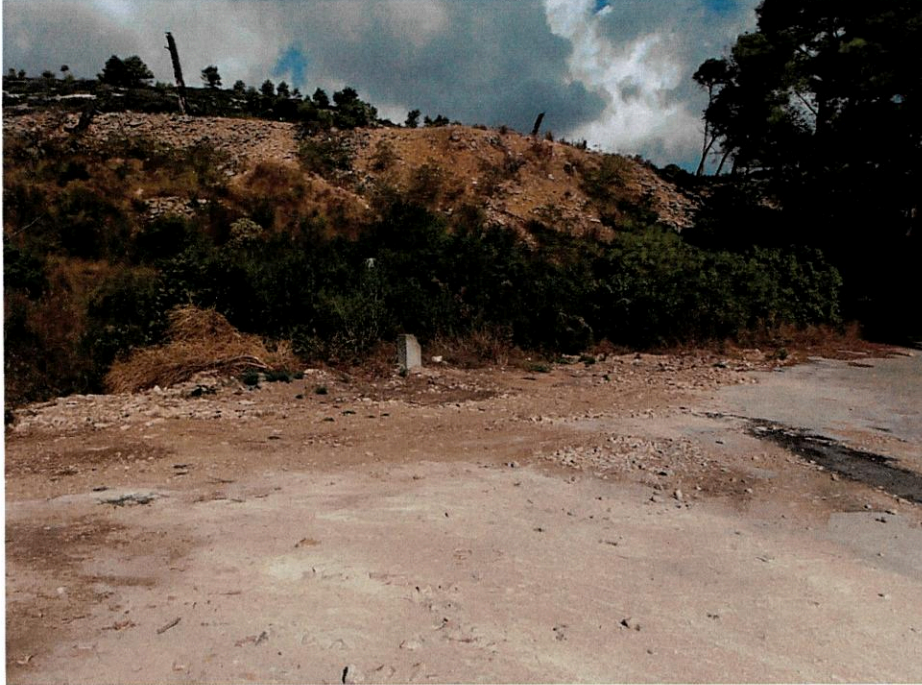
Photo n°1 : Déblais sur la zone de raccordement
