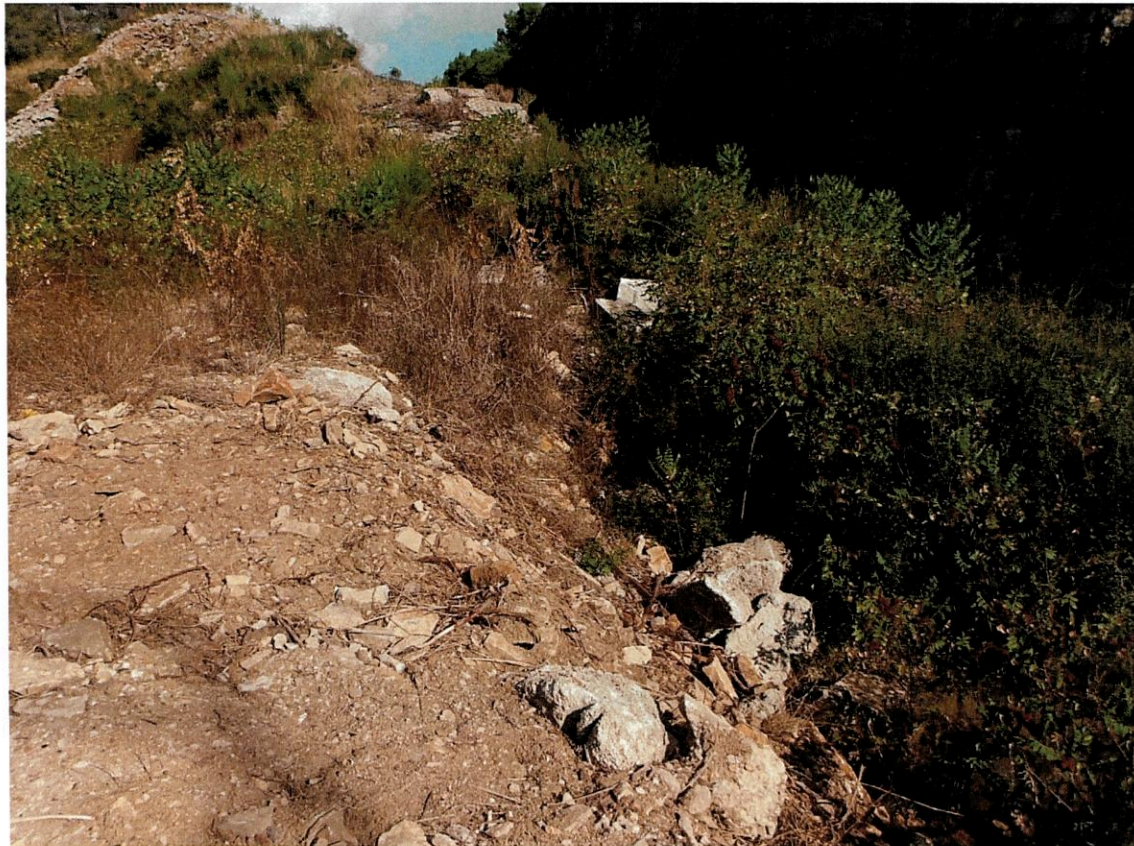
Photo n°4 : déblais entre le poste et la voie ferrée
