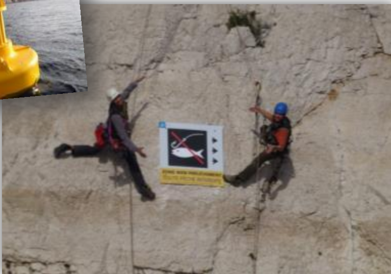
Pose de la signalisation à terre – Devenson © PNCaI
